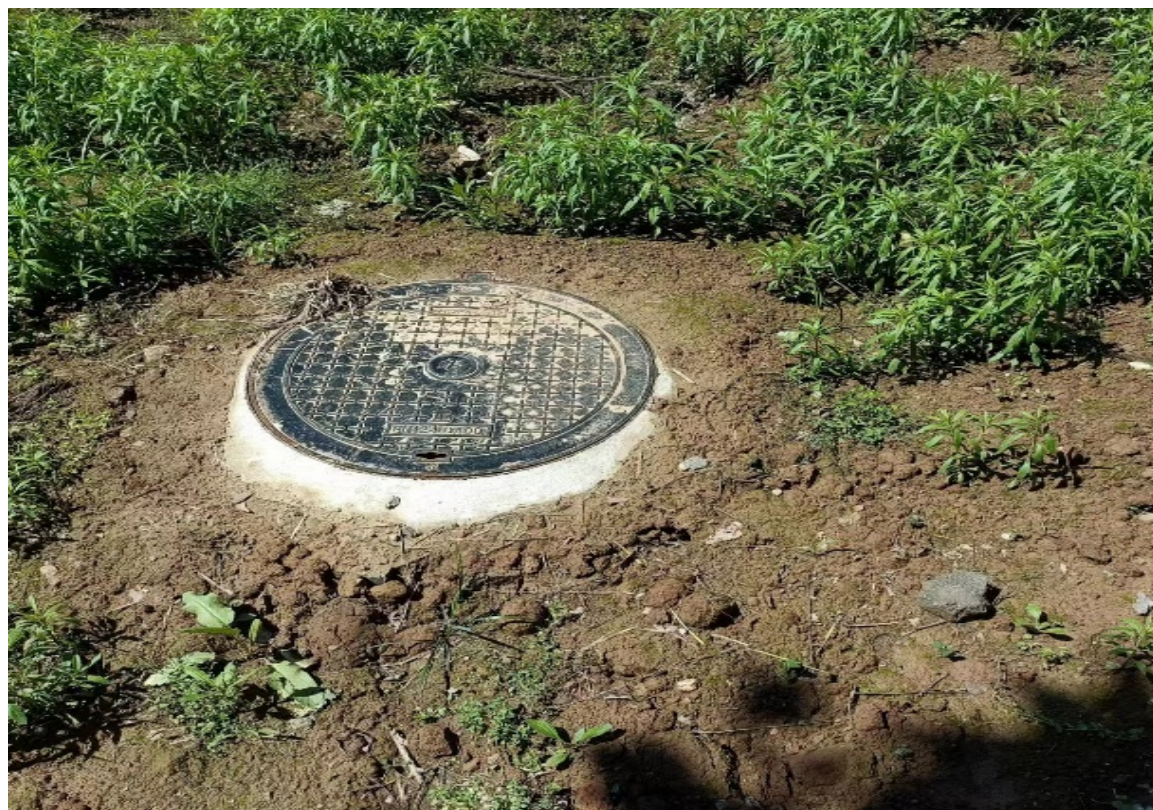
验收图片 6: 项目区雨水井
