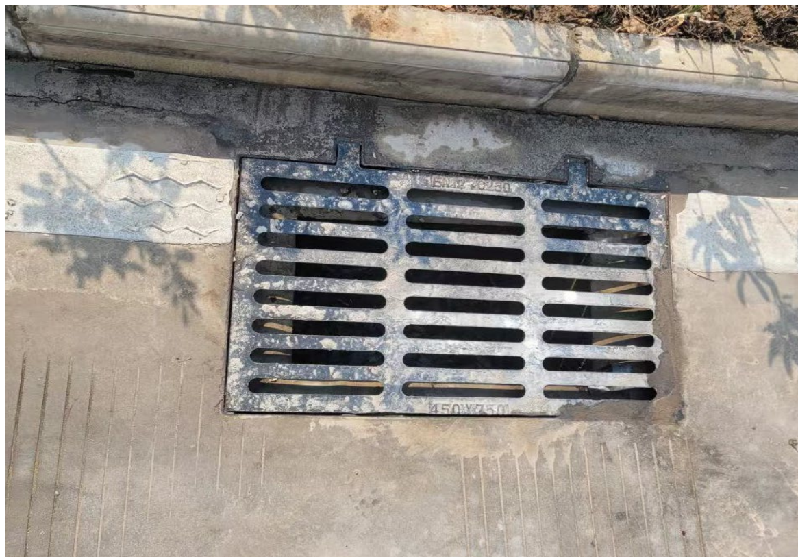
验收图片 5: 项目区雨水口
