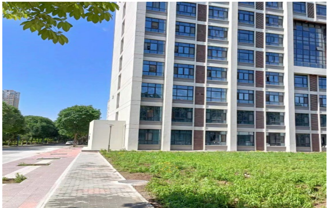
验收图片 2：透水铺装、雨水井及绿化
