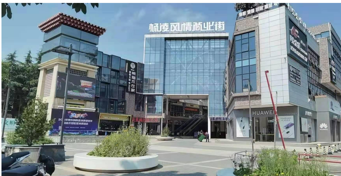
花池绿化、透水砖铺设（2021年6月）
