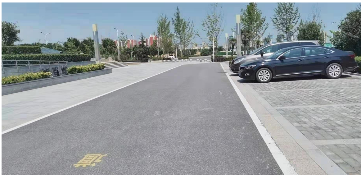
路面硬化（2021年6月）
