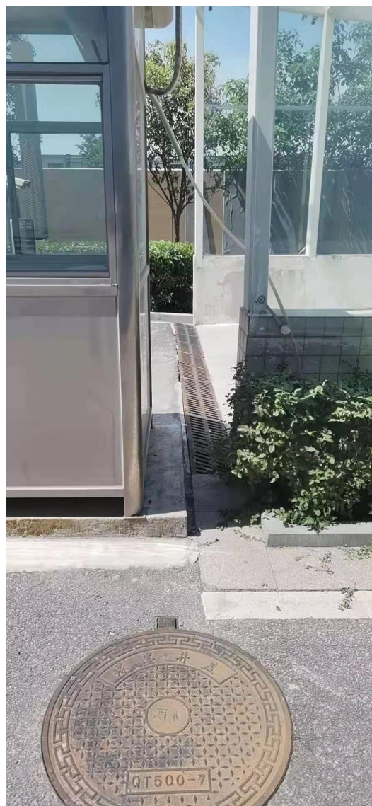
排水暗沟、雨水口 (2021年6月)
