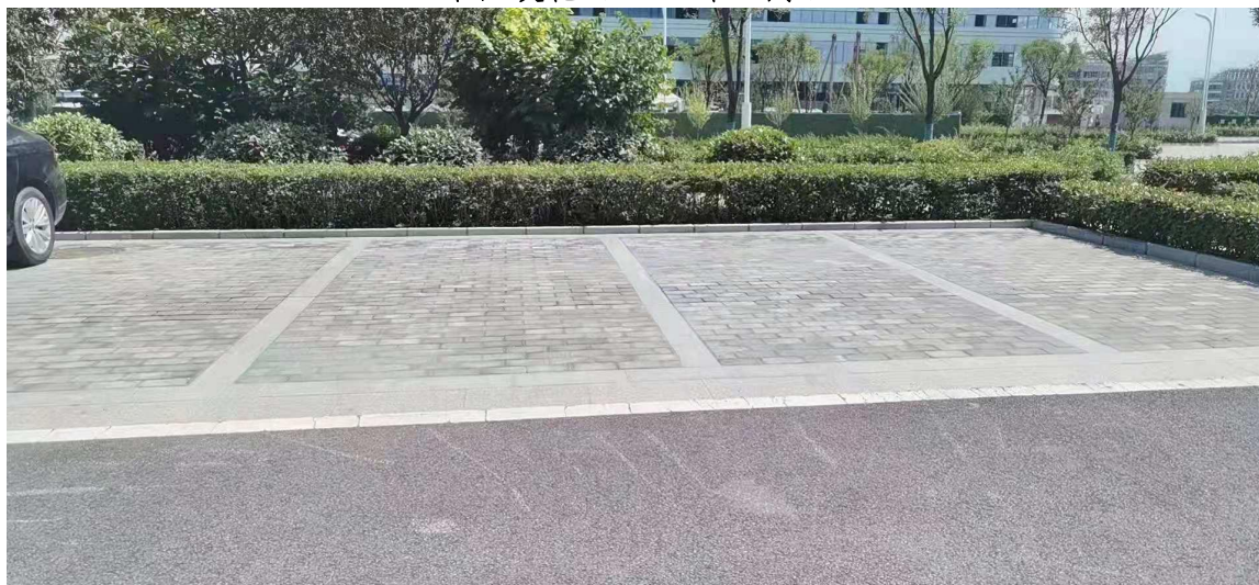
路面硬化、园林绿化（2021年6月）
